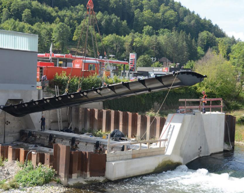
**ZWEITE WEHRKLAPPE EINGEHOBEN UND POSITIONIERT**
