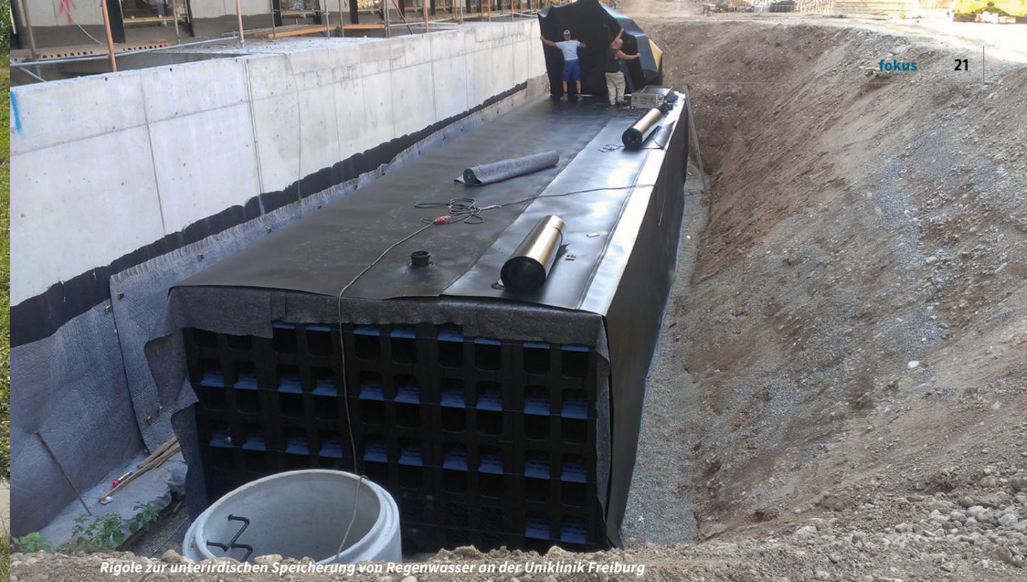
Rigole zur unterirdischen Speicherung von Regenwasser an der Uniklinik Freiburg
