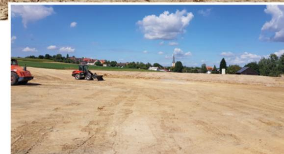
Die Bauarbeiten im Hochwasserrückhaltebecken in Amrichshausen sind in vollem Gang. Mit 5.000 Kubikmetern Fassungsvermögen soll das Becken den nahen Ortskern von Amrichshausen in Zukunft vor Starkregen schützen
